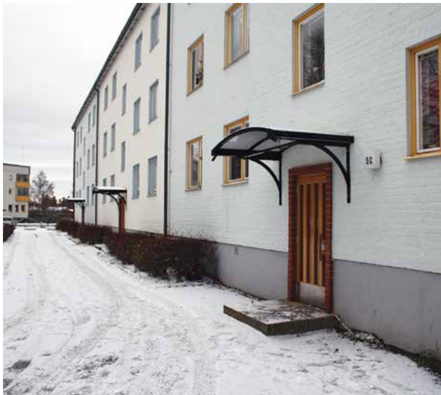
Här på Gammeltorpsvägen 3 och 5 har nya skärmtak satts upp ovanför den nya entréportarna.
