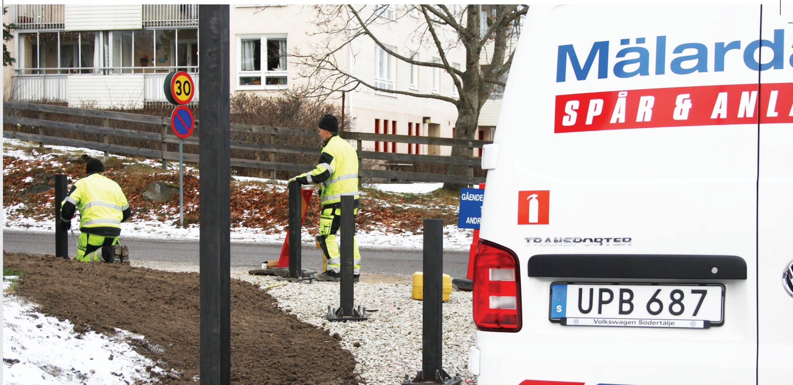
Just nu kan vi se Mälardalens Spår & Anläggning bland annat vid Karaffen, där de sätter upp ett bullerplank vid den nya busshållplatsen.
