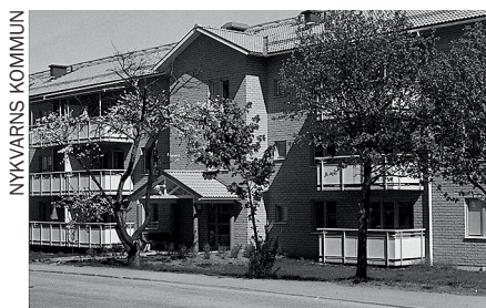
Järnavägen 1991, före Nybos tid.
